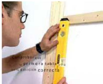
3.-Fije los frisos utilizando grapas o puntas, nunca utilice cola u otro adhesivo, debido a que impide el movimiento natural de la madera y puede ocasionar roturas. Es aconsejable evitar que las tablas lleguen al suelo y al techo. Se recomienda dejar unos dos centímetros de separación en total (sea hasta el suelo, techo o ambos).
